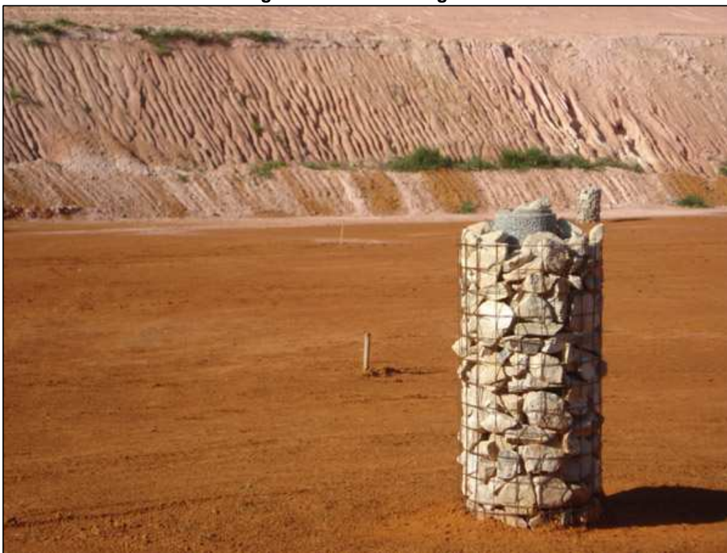
Figura 10.4. Dreno de gases.
