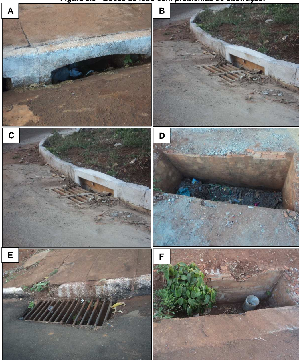
Figura 9.5 - Bocas de lobo com problemas de obstrução.
