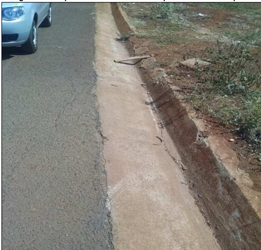
Figura 9.7. Dispositivo de escoamento superficial de Indianópolis.
