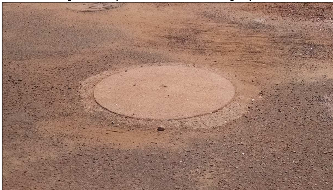
Figura 9.4. Poço de visita de rede de drenagem pluvial.
