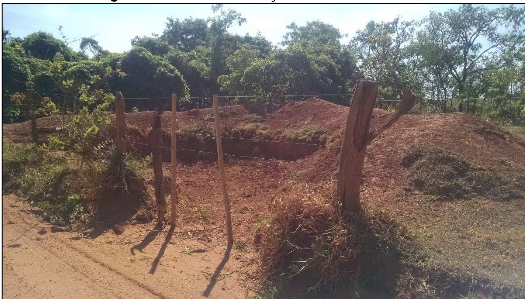
Figura 9.3. Bacia de contenção nas estradas vicinais.
