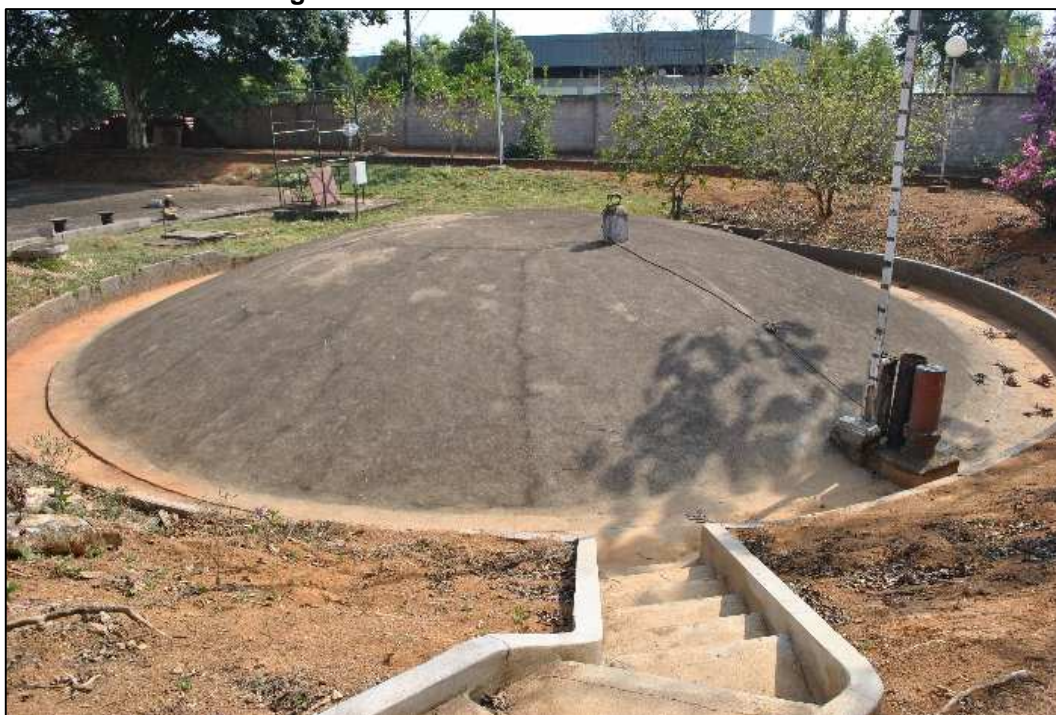
Figura 7.12. Reservatório enterrado 600m³.
