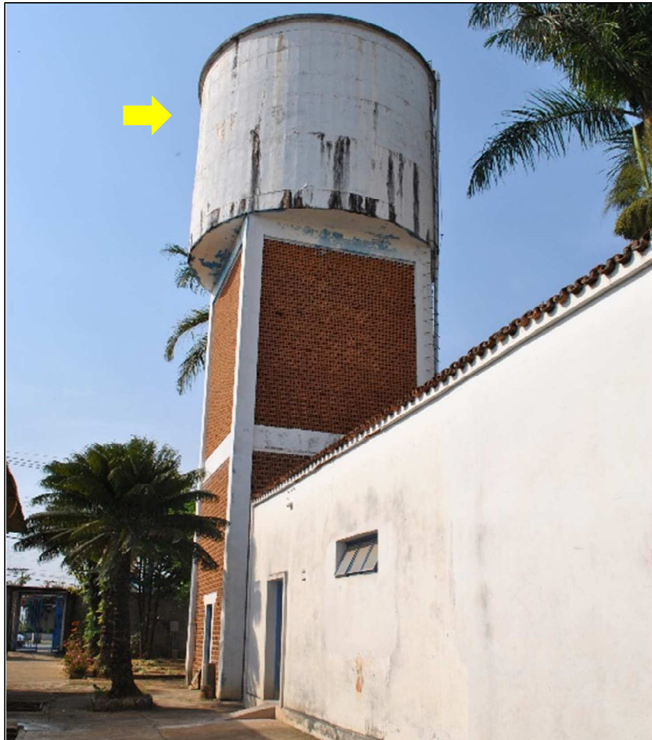
Figura 7.14. Reservatório elevado de 227m³.
