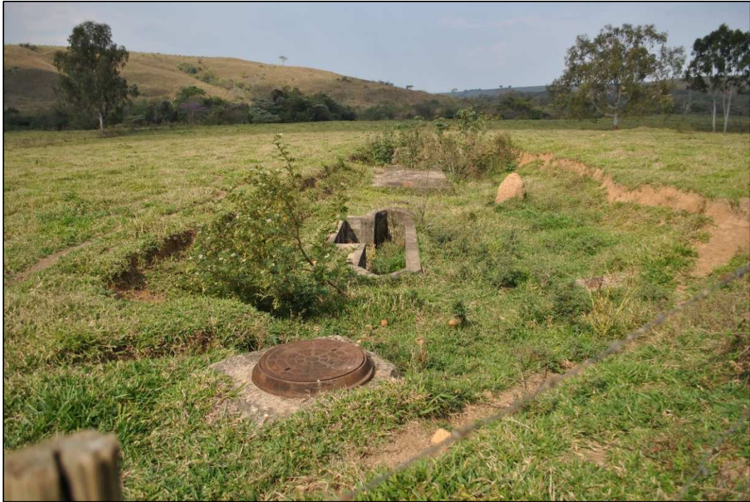
Figura 8.2. Unidade de tratamento desativada.
