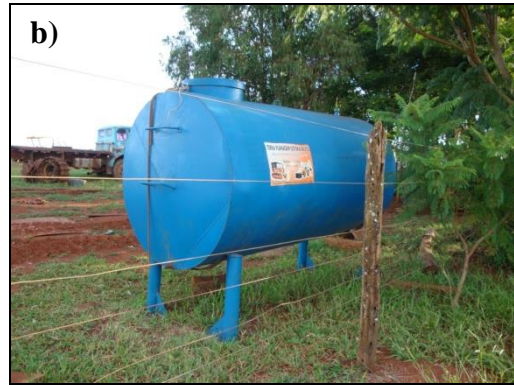
Figura 15 – a) Observa-se um sistema de bombeamento de água de um poço tubular, b) notamos um tanque de combustível instalado de forma irregular, sem a construção de um muro de contenção e piso impermeável. Fonte: Raiz Ambiental Ltda.
