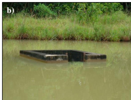
Figura 104 – a) Mostra o detalhe da passarela sobre as águas do açude/barramento, b) detalhe do monge no interior do mesmo, ferramenta utilizada para controle do nível e fluxo de água.
