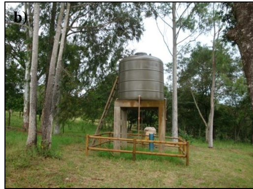
Figura 110 – a) poço tubular utilizado para abastecimento da propriedade, b) reservatório elevado utilizado para armazenamento da água oriunda do poço.
