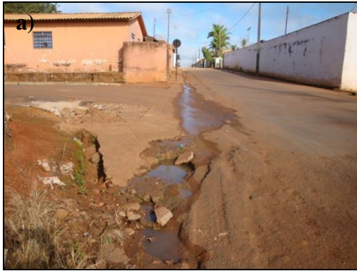
Figura 324 – a) e b) Vias pavimentadas no entrono no Município de Santa Juliana, mostrando ponto de estragos gerados pela água pluvial. Devido à ausência de redes de drenagem no município.
