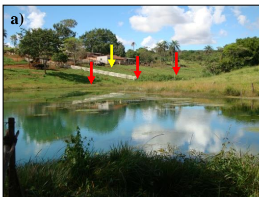
Figura 188 – a) Vista frontal do barramento. Ao fundo avista-se a área do curral e a sede da propriedade. A seta vermelha indica o trajeto do leito do Córrego Capão da Erva, até chegar ao barramento. A seta amarela indica o ponto em que ocorre o carreamento de dejetos do curral para o Córrego, b) vista de área inundada (afloramento do lençol), abaixo do barramento. Observa-se que da mesma forma que o barramento, não a vegetação na Área de
