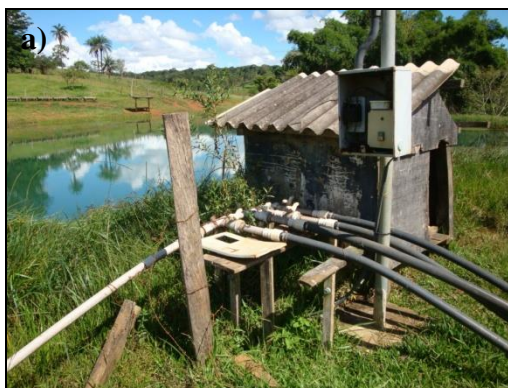
Figura 187 – a) Conjunto moto-bomba instalado às margens do barramento, com a finalidade de captação para irrigação de pastagem, b) vista de um ponto de dessedentação e nutrição animal, na margem esquerda do barramento, próximo ao ponto do vertedouro.
