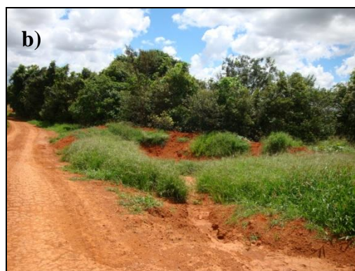
Figura 266 – a) Vista da estrada de acesso á propriedade. Observa-se a existência de curvas de nível, b) bolsão destinado à contenção de águas pluviais.
