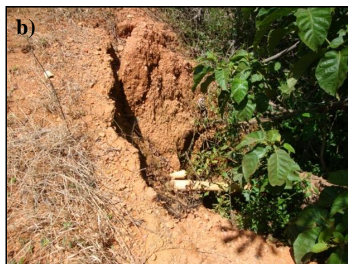
Figura 175 – a) e b) As figuras mostram o mesmo barramento, que possui problemas com talude, pelo derramamento por sobre o mesmo, visto possível mau dimensionamento e o excesso de águas pluviais. Fonte: Raiz Ambiental Ltda.
