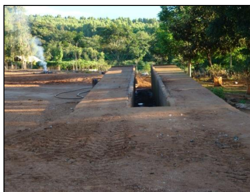
Figura 220 – Vista de uma rampa de elevação utilizada para veículos, equipamentos e maquinários em manutenção. Nota-se que não há impermeabilização do solo ao redor nem sistema de contenção de líquidos/efluentes. Assim observou-se presença de manchas de óleo e graxa nas áreas próximas.
