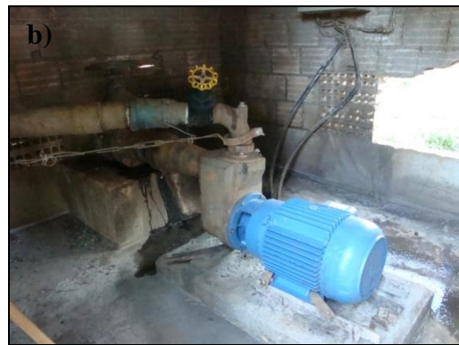
Figura 214 – a) Vista externa da casa do conjunto moto-bomba, utilizado para realização do processo de fertirrigação com dejetos, b) vista interna da casa, com visão do conjunto moto-bomba. Fonte: Raiz Ambiental Ltda.
