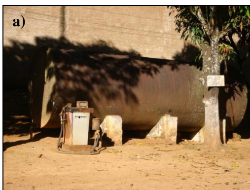
Figura 202 – a) Vista lateral de tanque de combustíveis. Notam-se pontos de irregularidade, como: falta de muro de contenção, piso impermeável, caixa de contenção, assim como a impermeabilização do piso na área de abastecimento, à frente da bomba de combustível, b) vista frontal de barracão utilizado para armazenagem de insumos, equipamentos e maquinários.
