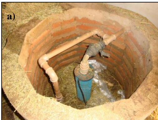
Figura 111 – a) Poço tubular utilizado para abastecimento da propriedade, b) filtro para tratamento da água oriunda do poço.
