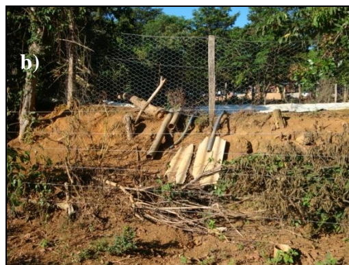
Figura 207 – a) e b) Vistas de diferentes ângulos do tanque de dejetos. Observam-se problemas de conservação do tabule realizado para a construção do mesmo. Havendo risco real de rompimento do mesmo e contaminação de uma vasta área de solo e do manancial hídrico mais próximo (afluentes do Córrego Capão da Erva).
