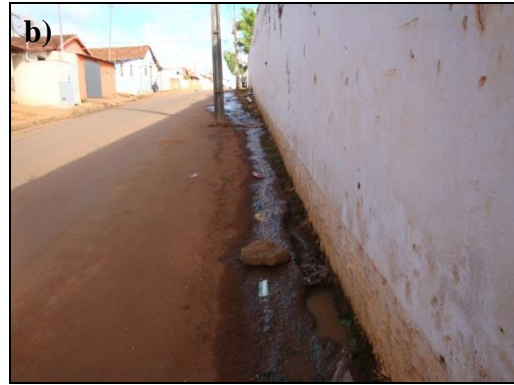
Figura 324 – a) e b) Vias pavimentadas no entrono no Município de Santa Juliana, mostrando ponto de estragos gerados pela água pluvial. Devido à ausência de redes de drenagem no município.
