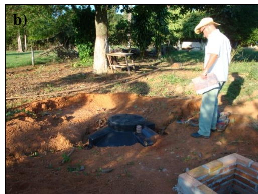
Figura 218 – a) Vista lateral de residências de funcionários, em construção, b) vista de sistema de tratamento de efluente, fossa séptica, adequada, conforme padrões da ABNT. Com o objetivo de tratar os efluentes sanitários gerados nas residências.
