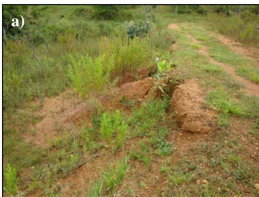
Figura 46 – a) Observa-se o talude do barramento danificado pelo processo de erosão no período chuvoso, b) observa-se uma estrutura que é utilizada para ordenha (Curral). Fonte: Raiz Ambiental Ltda.
