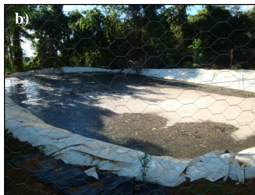
Figura 206 – a) Vista da tubulação que conduz os dejetos suínos produzidos na área das granjas, até uma das lagoas de estabilização. Nota-se na indicação da seta vermelha, vazamento de efluente e contaminação do solo próximo, b) vista de uma das lagoas de contenção/equalização de dejetos. Observou-se que a lagoa está “impermeabilizada” com uma lona inapropriada, pois nestes casos emprega-se uma geomembrana de Polietileno de Alta Densidade - PEAD, contudo, neste caso foi utilizada uma lona simples, dupla face de Polietileno de Baixa Densidade – PEBD. Fonte: Raiz Ambiental Ltda.
