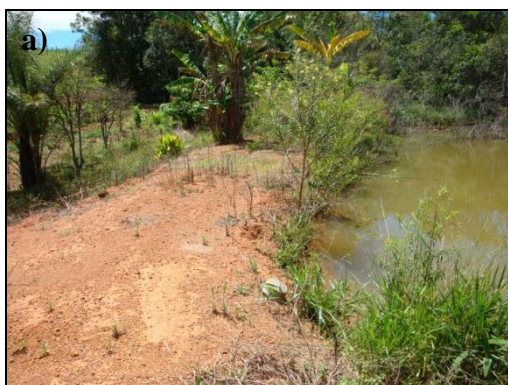
Figura 175 – a) e b) As figuras mostram o mesmo barramento, que possui problemas com talude, pelo derramamento por sobre o mesmo, visto possível mau dimensionamento e o excesso de águas pluviais. Fonte: Raiz Ambiental Ltda.
