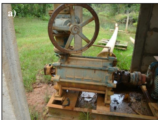
Figura 141 – a) Detalhe da bomba utilizada para captação da água do barramento, b) barramento abastecido com água do Córrego Capão da Erva. Reservatório este utilizado para irrigação da área de lavoura.
