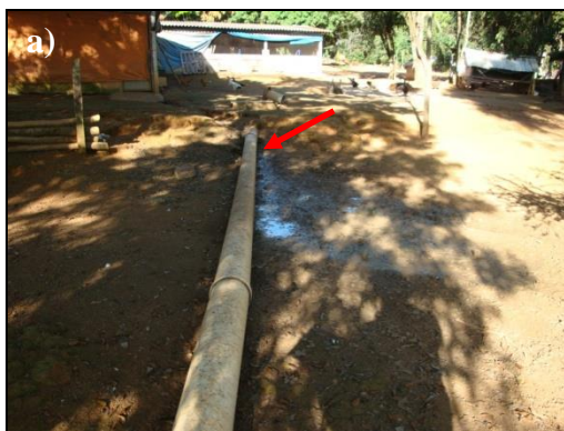
Figura 206 – a) Vista da tubulação que conduz os dejetos suínos produzidos na área das granjas, até uma das lagoas de estabilização. Nota-se na indicação da seta vermelha, vazamento de efluente e contaminação do solo próximo, b) vista de uma das lagoas de contenção/equalização de dejetos. Observou-se que a lagoa está “impermeabilizada” com uma lona inapropriada, pois nestes casos emprega-se uma geomembrana de Polietileno de Alta Densidade - PEAD, contudo, neste caso foi utilizada uma lona simples, dupla face de Polietileno de Baixa Densidade – PEBD. Fonte: Raiz Ambiental Ltda.
