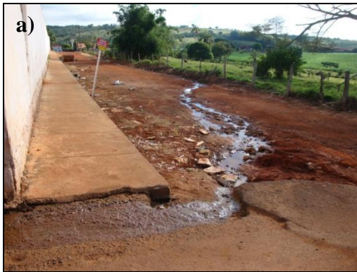
Figura 325 – a) e b) Vias pavimentadas no entrono no Município de Santa Juliana, mostrando ponto de estragos gerados pela água pluvial. Devido à ausência de redes de drenagem no município.
