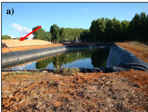
Figura 215 – a) Vista do tanque reservatório de efluente tratado, após a passagem do mesmo pelo biodigestor, localizado cima indicado pela seta vermelha, b) detalhe do conjunto moto-bomba utilizado para recalque do efluente utilizado na fertirrigação nas áreas de pastagem. Fonte: Raiz Ambiental Ltda.
