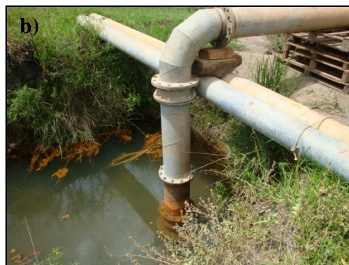
Figura 261 – a) Detalhe de vazamento de combustível abaixo do motor, b) detalhe da tubulação de recalque do conjunto. Foi realizada escavação no leito do Córrego para facilitar a captação da água.
