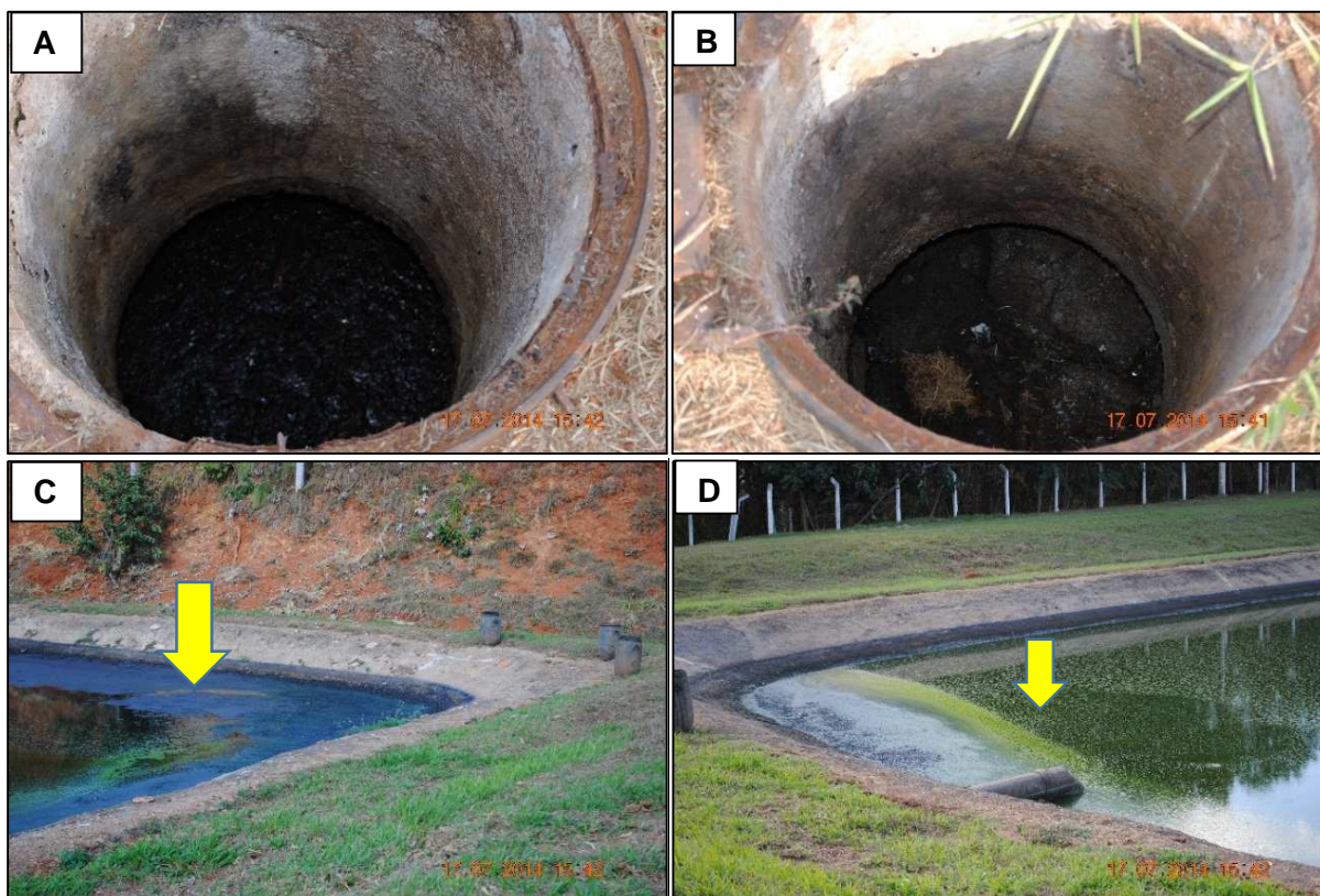
Figura 8.6. Gradeamento em manutenção e desprendimento de lodo na lagoa.
