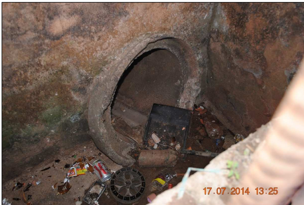
Figura 9.10. Detritos na tubulação de drenagem.
