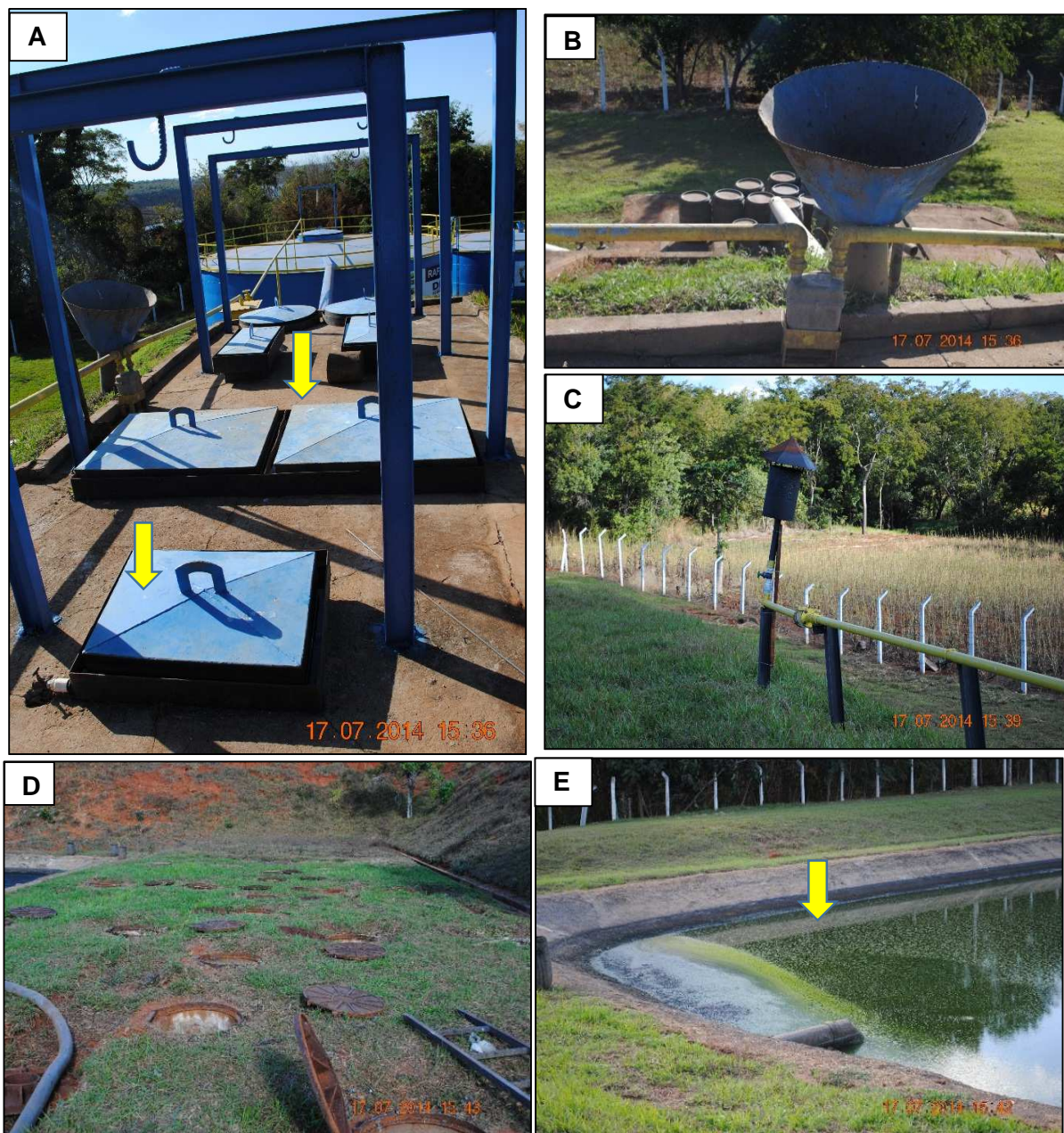
Figura 8.5. Gradeamento, medidor de vazão e tanque de recalque.
